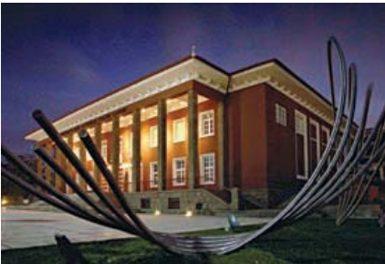
Dış cephe. Exterior façade.
