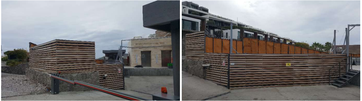
Şekil 7. Tasarım öncesi mevcut görünüş
